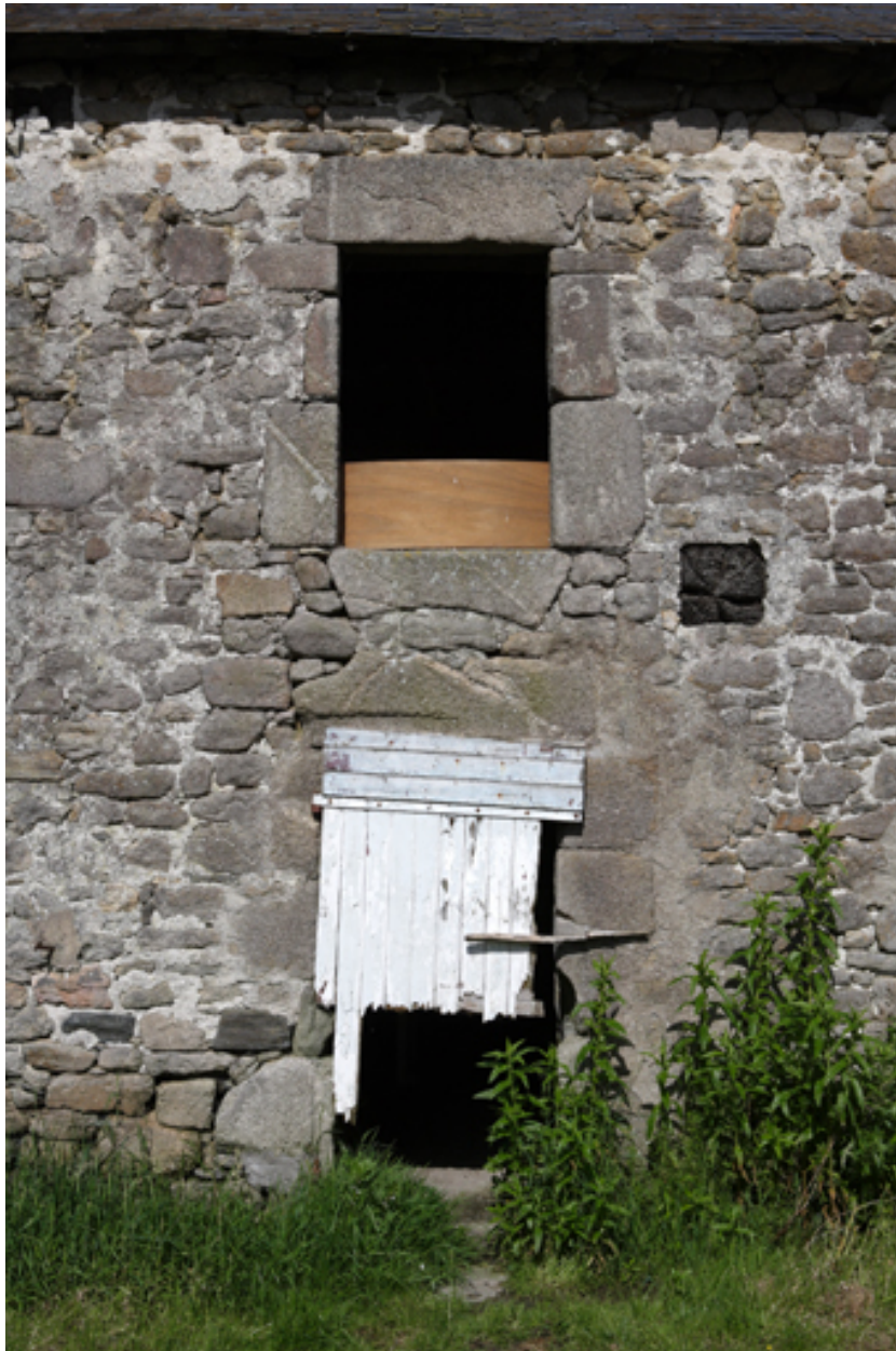
Dépendances. Façade est. Détail de la travée centrale.
