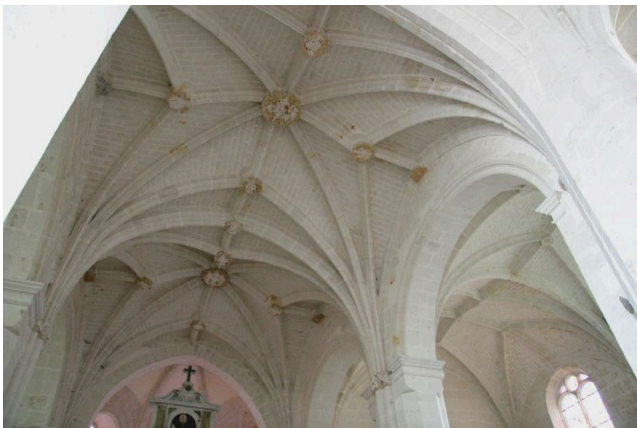
Voûtes du chœur.
