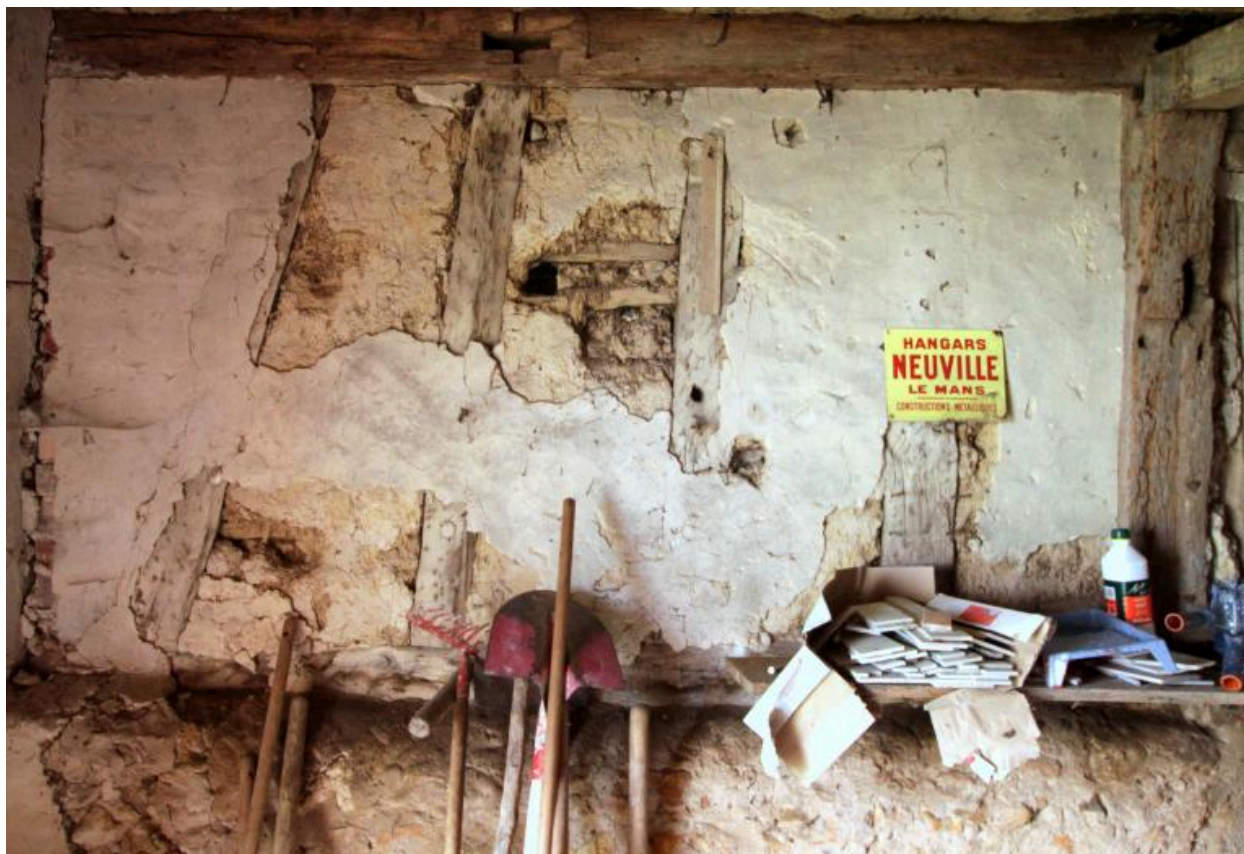
Maison : mur en pan de bois face à la cheminée.
