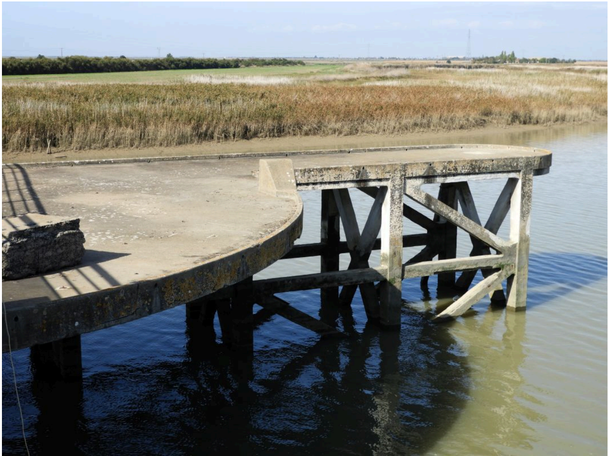
Eperon de la rive gauche du pont, côté amont.
