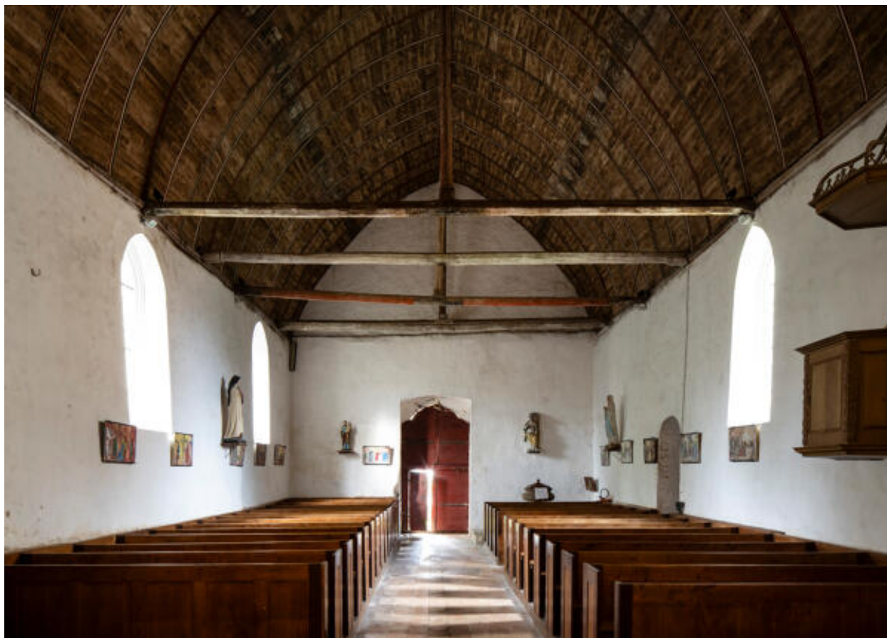
Nef vue depuis le chœur.
