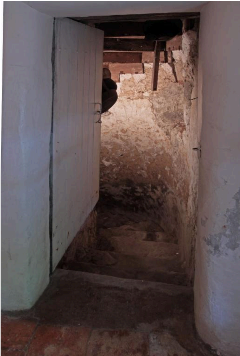
Maison, rez-de-chaussée : escalier en vis en pierre, menant à la cave.
