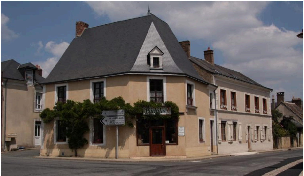
Angle 19, place André Ricordeau et 1, rue du Bourg ancien.
