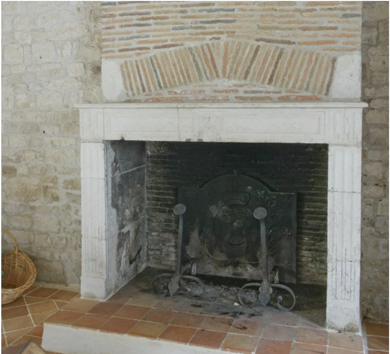
Cheminée de la pièce du rez-de-chaussée, en entrant à droite.
