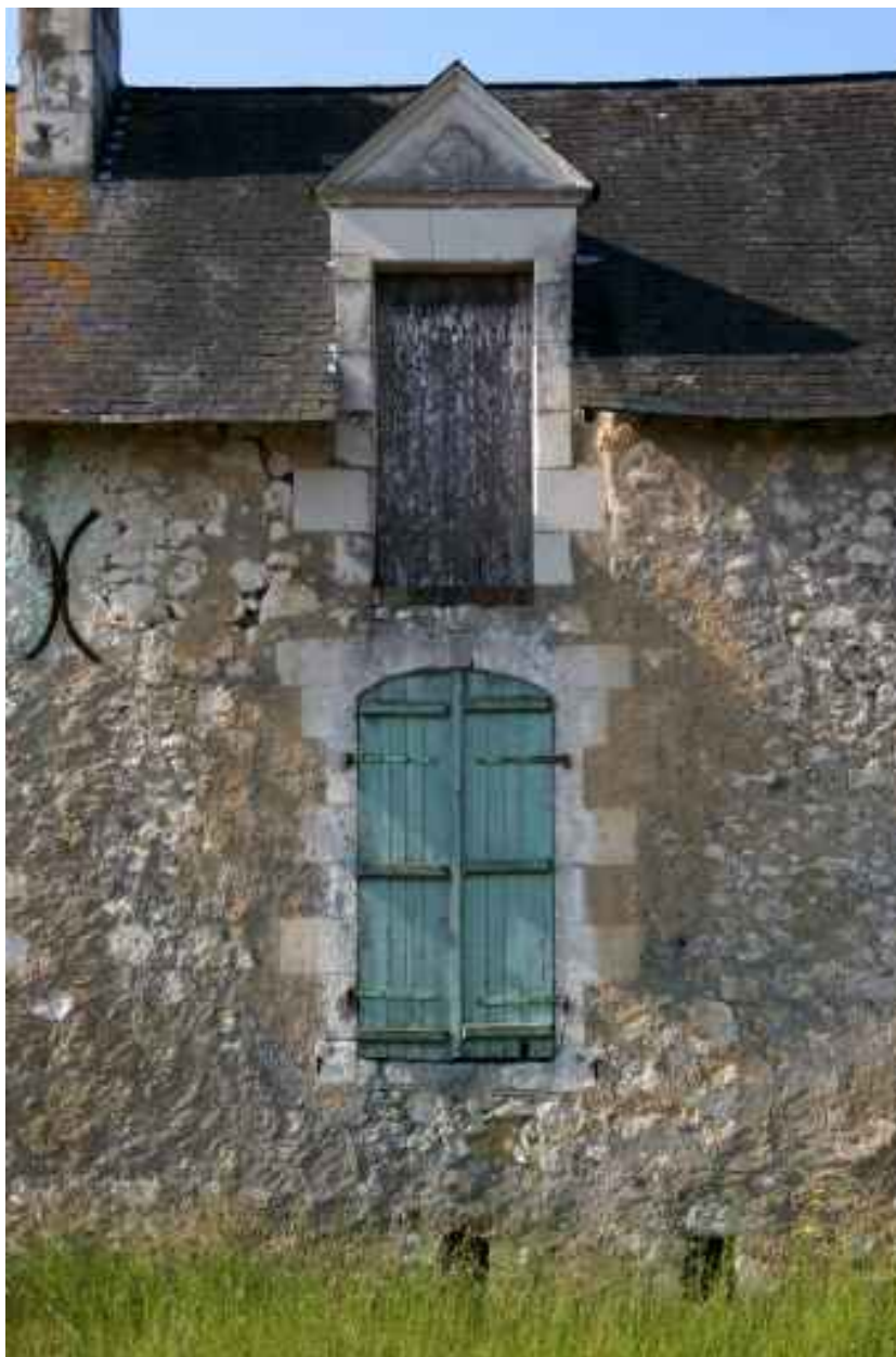
2e maison, détail : travée avec comble à surcroît.
