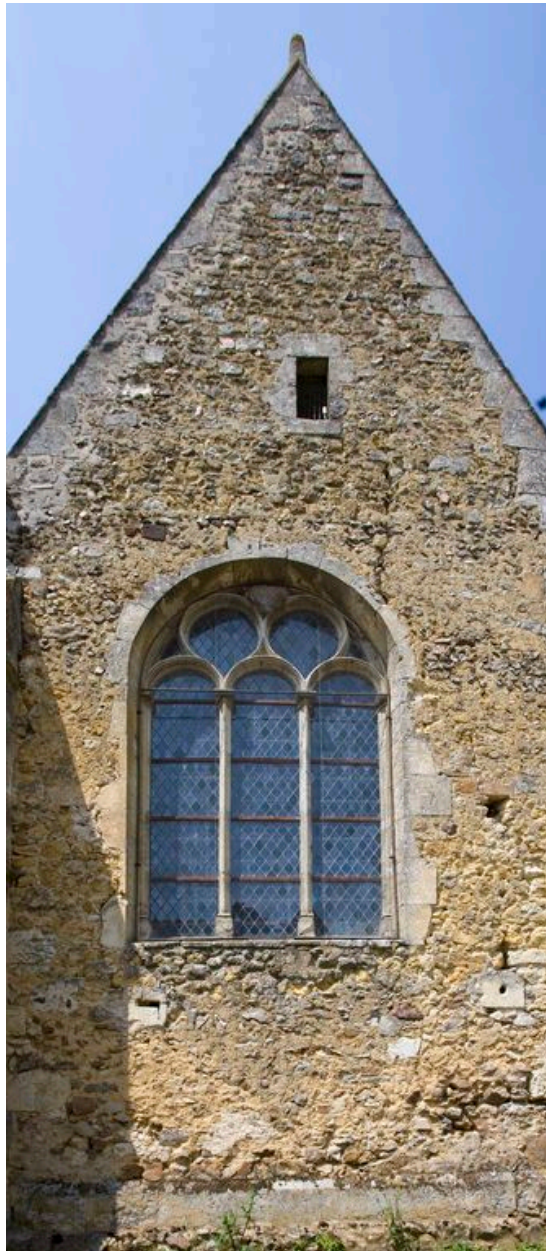
Fenêtre de la 5e travée du bas-côté sud
