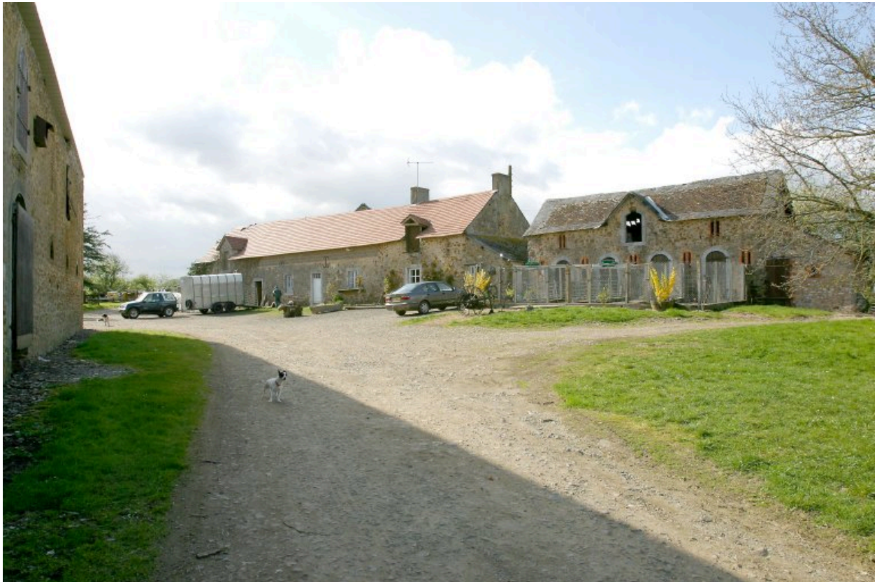
Le logis et la porcherie vus de l'est. A gauche, l'étable-grange.
