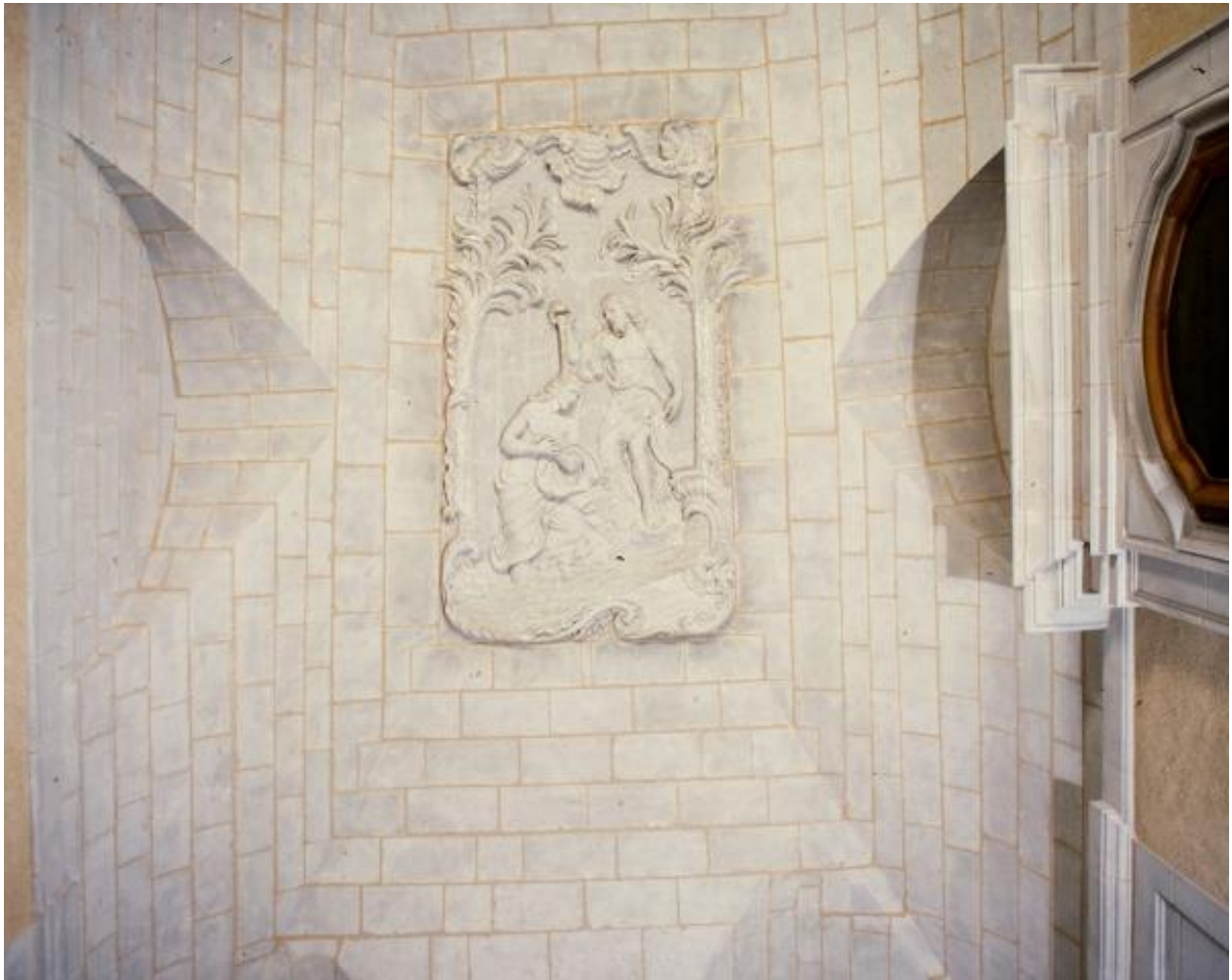
Aile sud de l'abbaye, salle du lavabo : la voûte.
