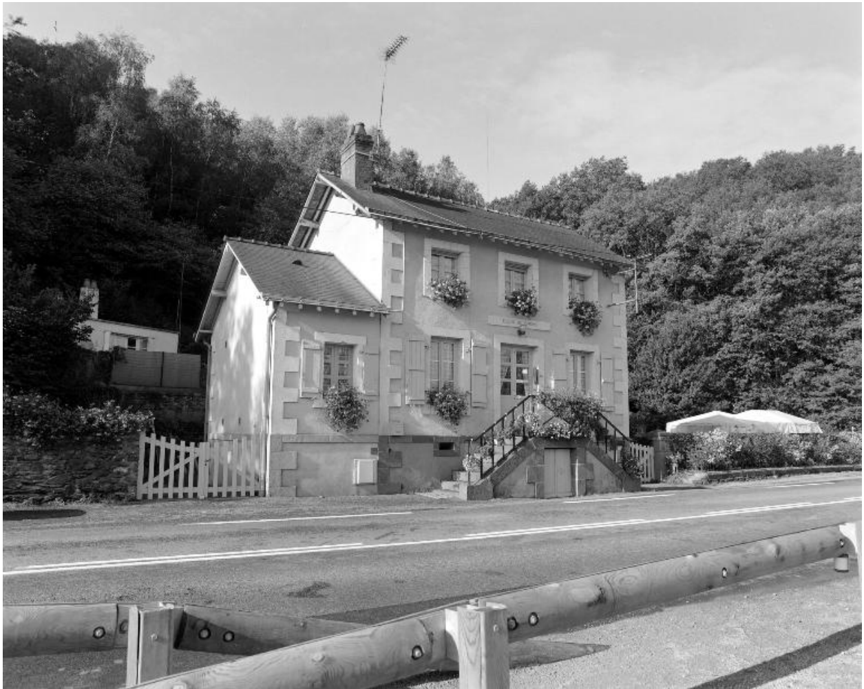
La maison éclusière.
