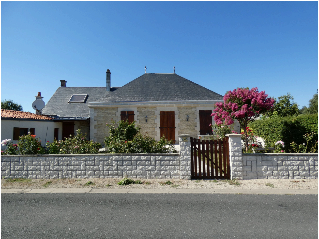
L'ancienne école, avec le jardin et l'ancien logement d'enseignant, vue depuis le sud.
