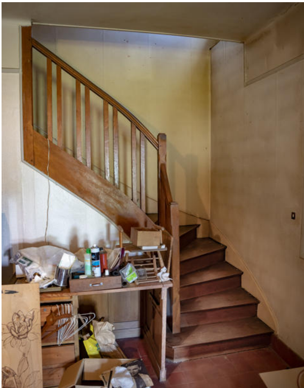
Vue de l'escalier d'un pavillon rue Icare.
