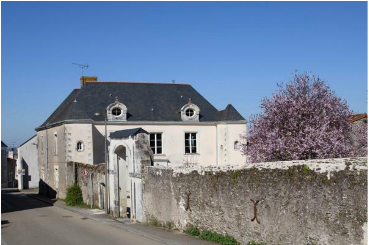
Vue d'ensemble depuis la rue des Mauges, au sud.
