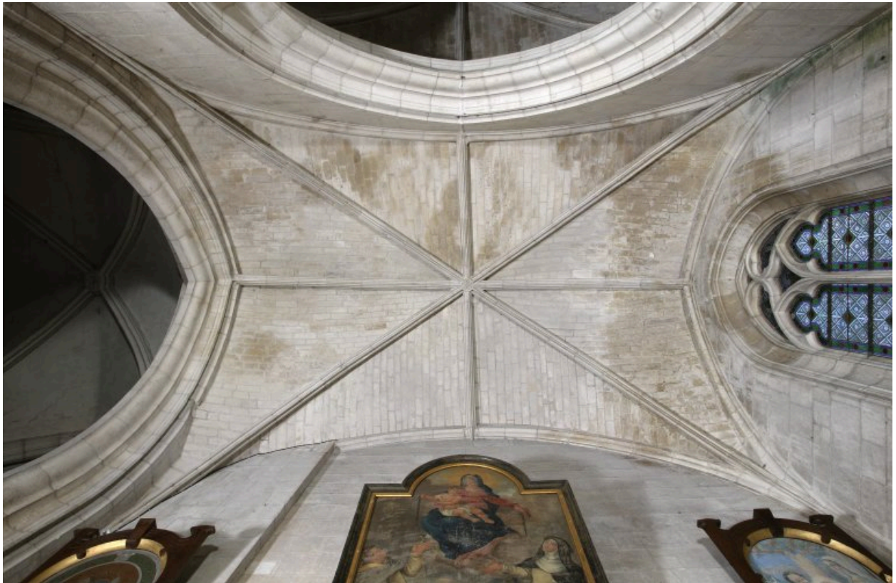
Quatrième chapelle du bas-côté nord de la nef : vue de la voûte.
