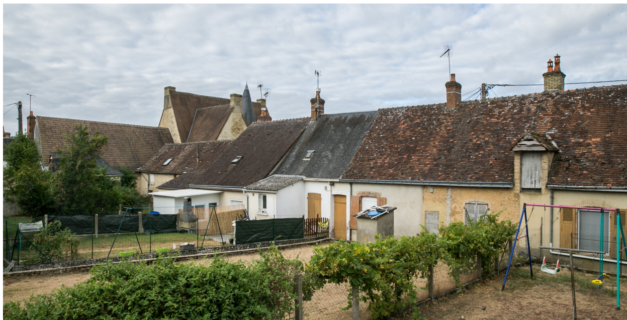
Les petites maisons de la cour des Victoires, façades postérieures.
