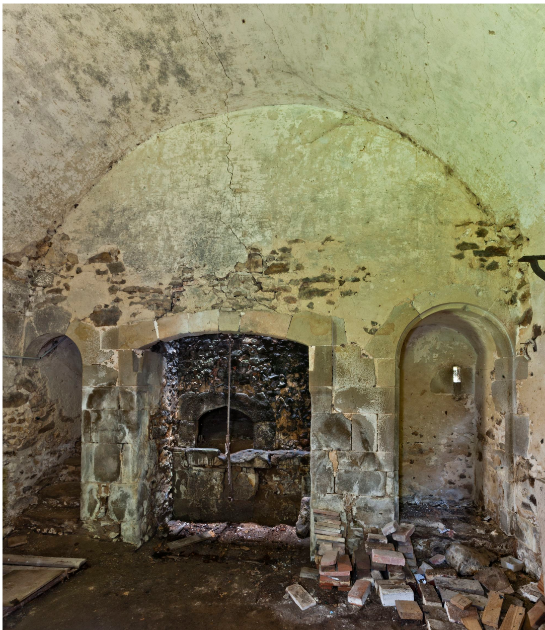
Vue intérieure du fournil, 1580 (sauf l'arc surbaissé couvrant la cheminée, refait).
