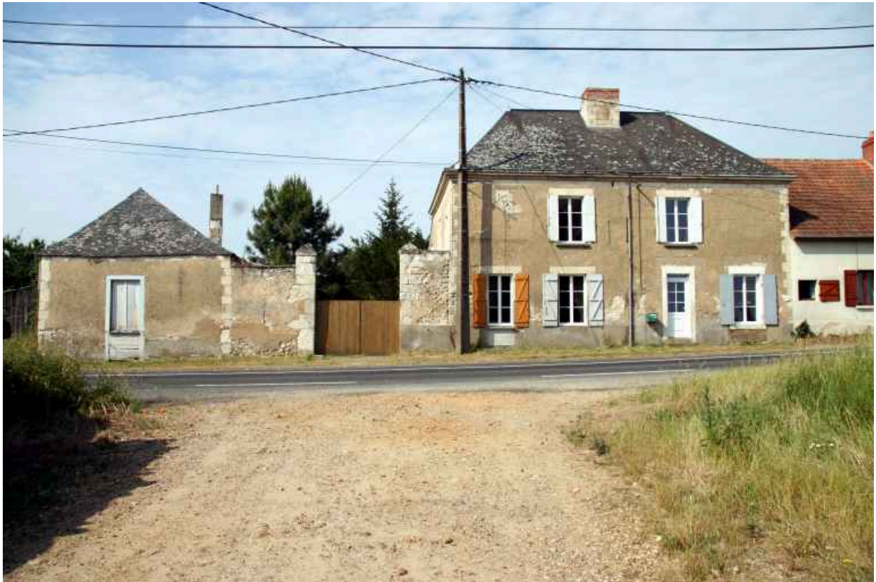
Le Raillon, maison 1 : façade sur la route de Château-la-Vallière.
