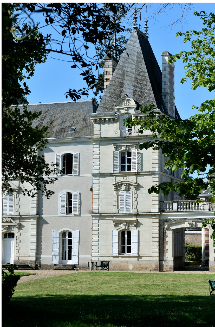
Façade est. Vue du pavillon nord.
