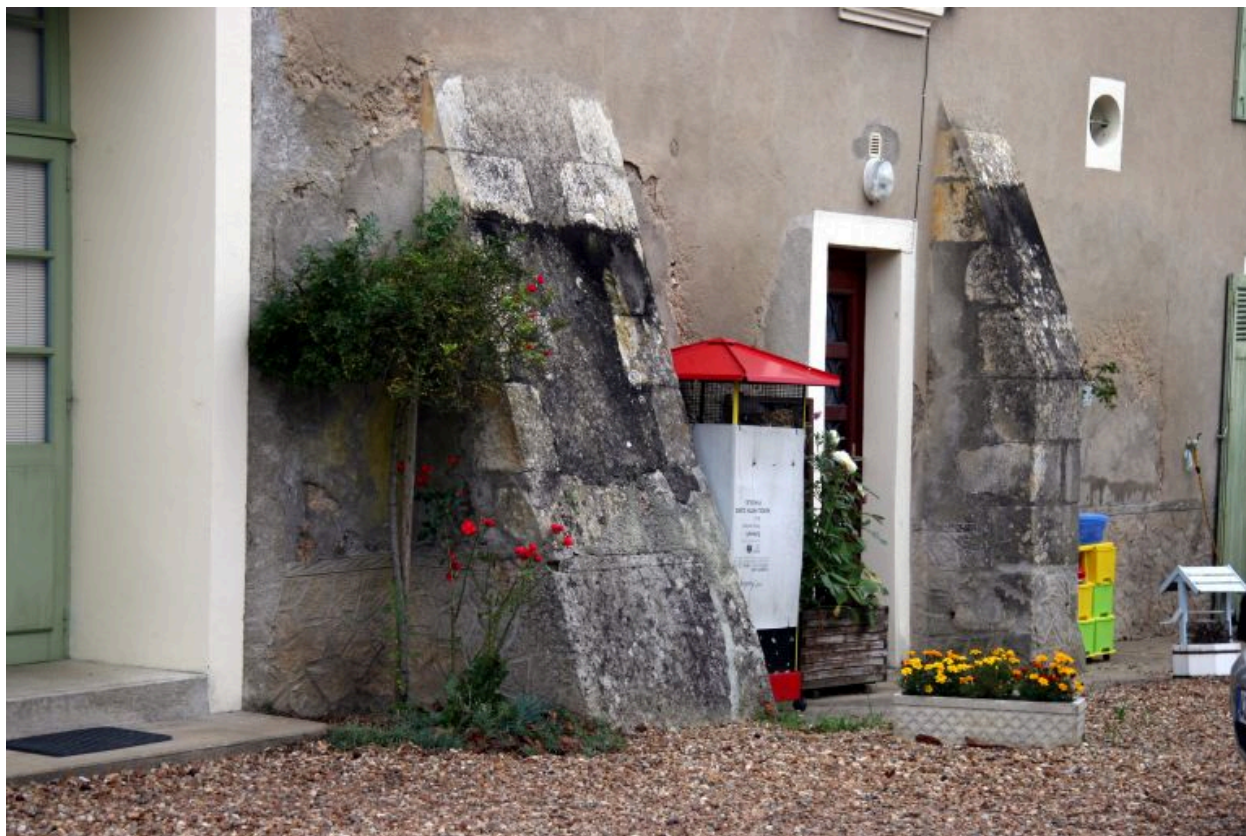
Façade antérieure sur cour, détail : contrefort.
