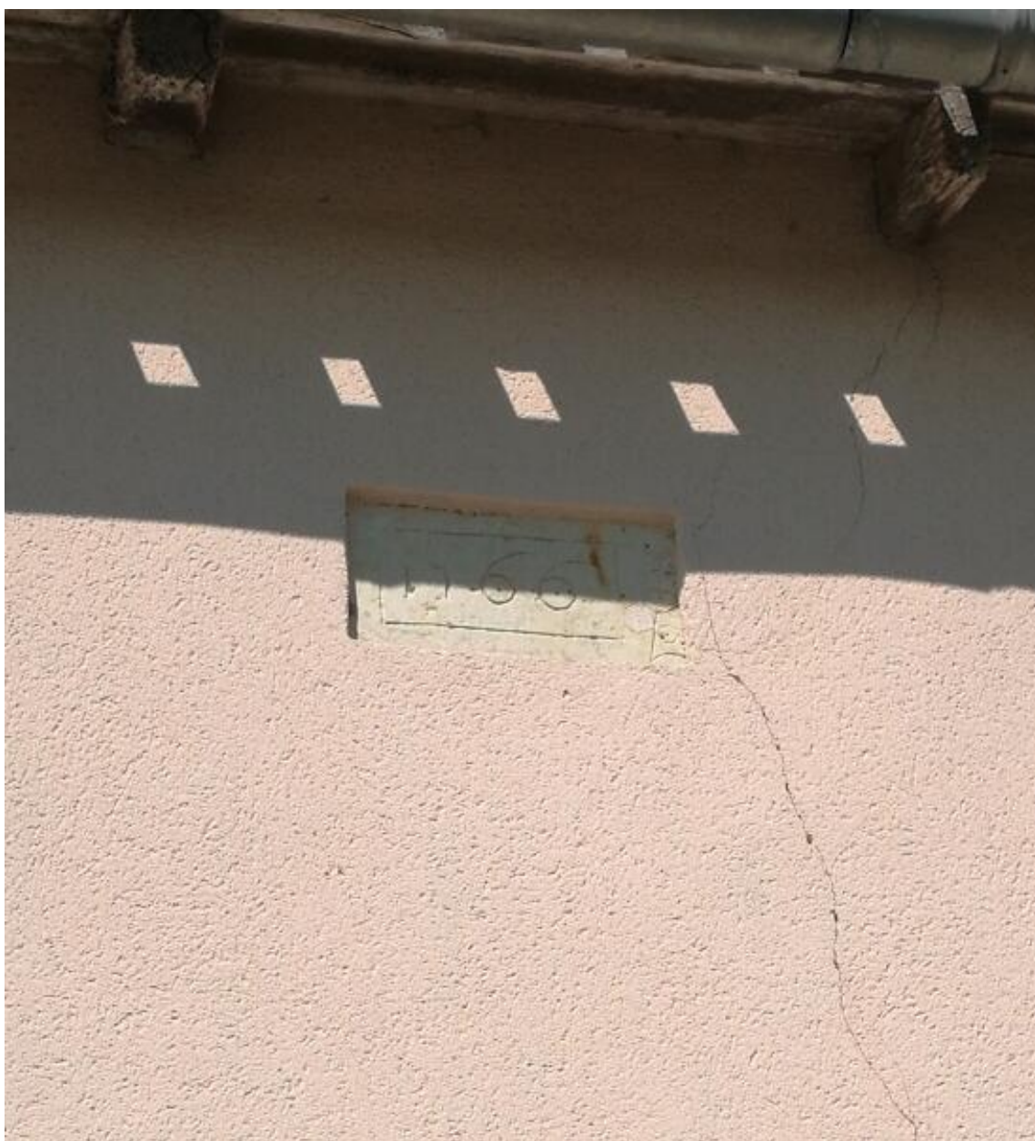
Le Plessis-Bitault. Détail de la date portée 1766.
