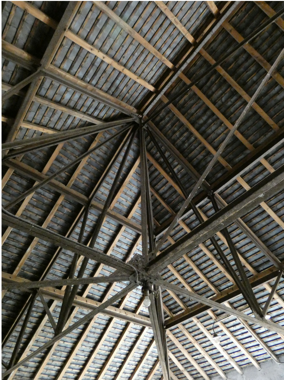
La charpente métallique du corps principal de bâtiment sud, côté est.
