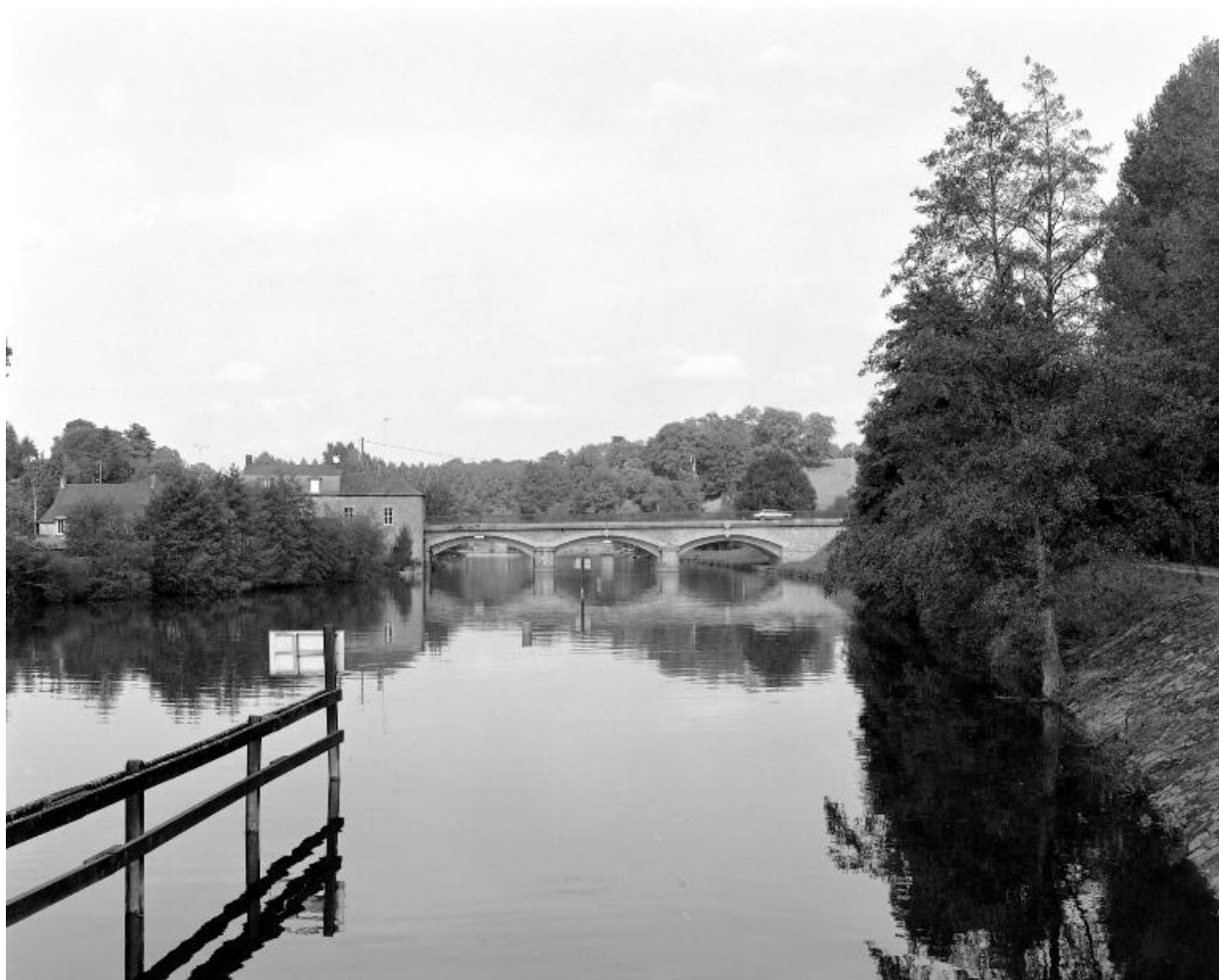
Le pont vu depuis la digue du canal des Communes en aval (au sud).
