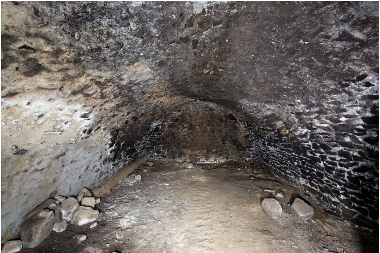
Le logis, vue intérieure. La cave vue depuis le sud.
