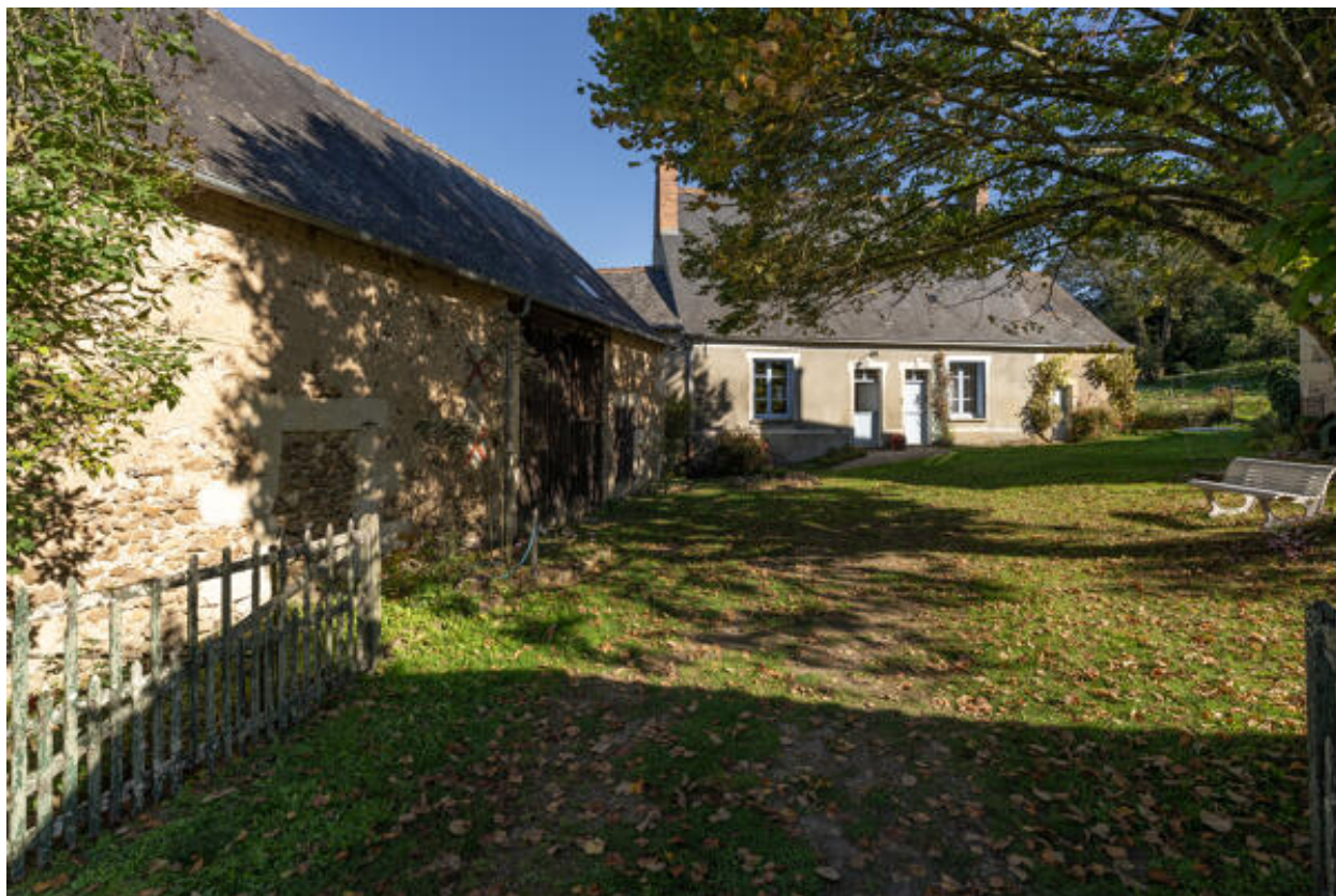
Ferme ouest : vue sur la cour avec grange-étable au premier plan et logis à l'arrière-plan.
