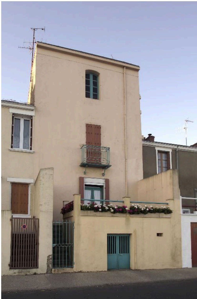
Maison, 102 rue du Général-De-Gaulle (côté quai).
