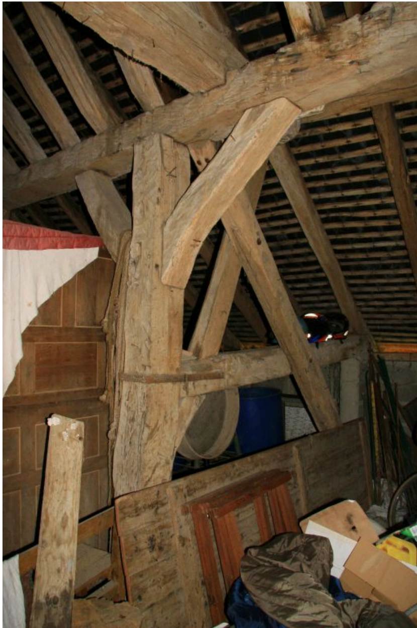
Grange sur poteau avec un bas-côté.
