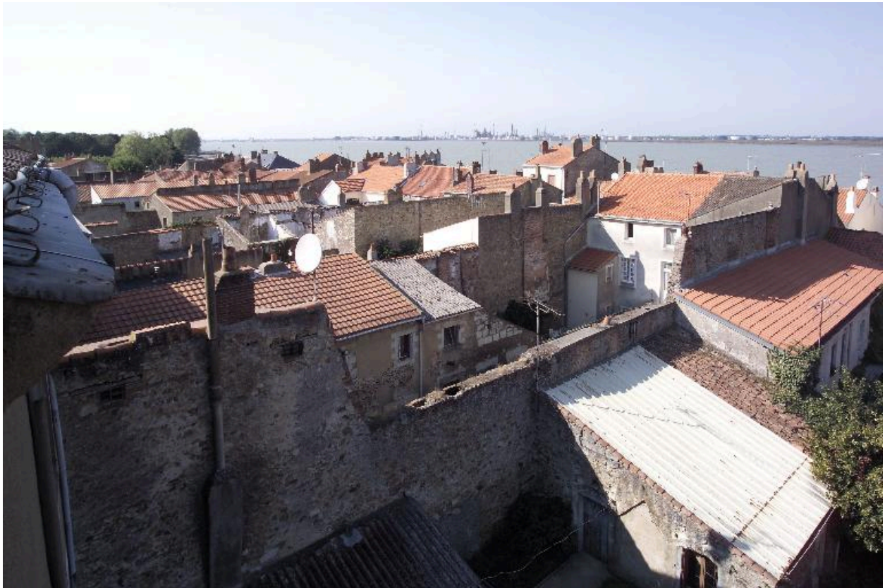
La façade postérieure de la maison n° 89 rue du Général-De-Gaulle.
