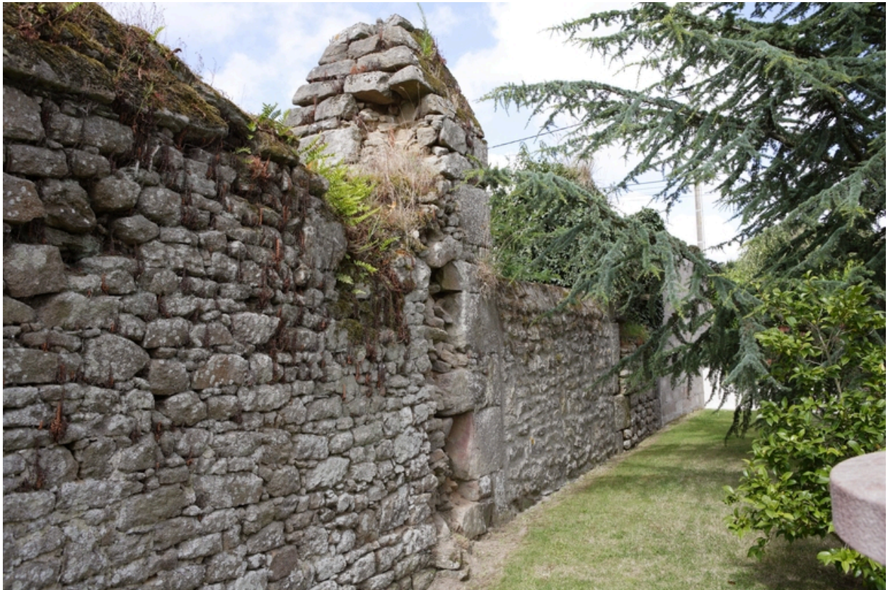
Vue du mur de clôture.
