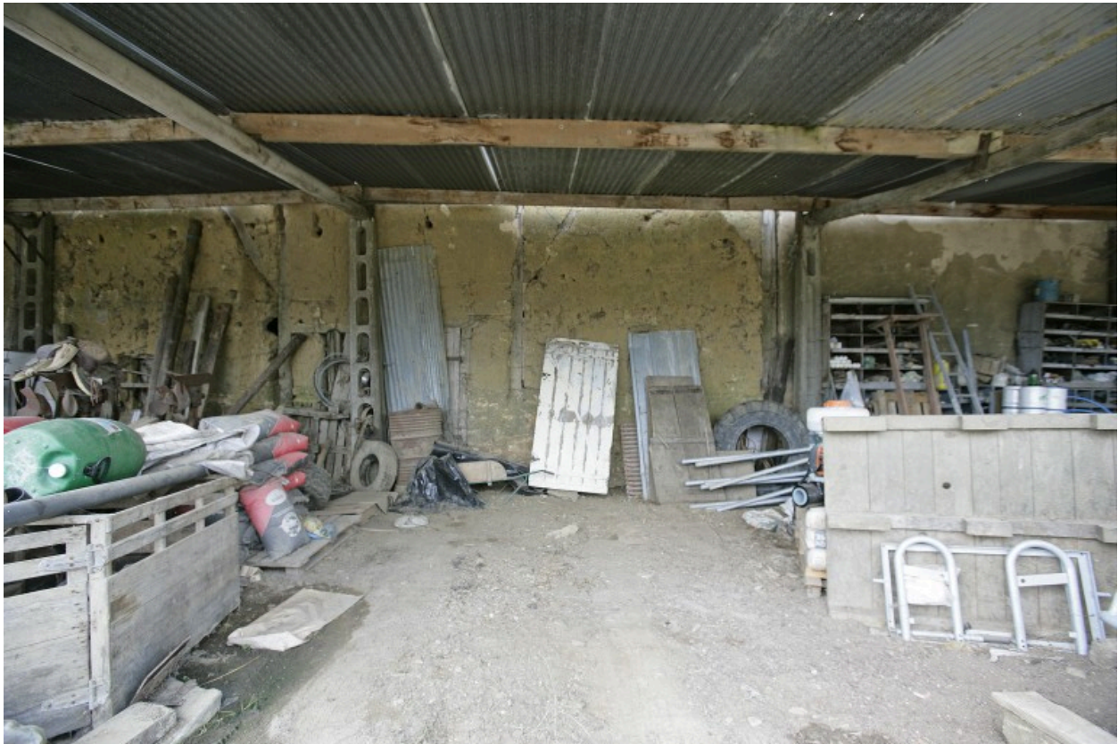
Grange : élévation postérieure en bauge.
