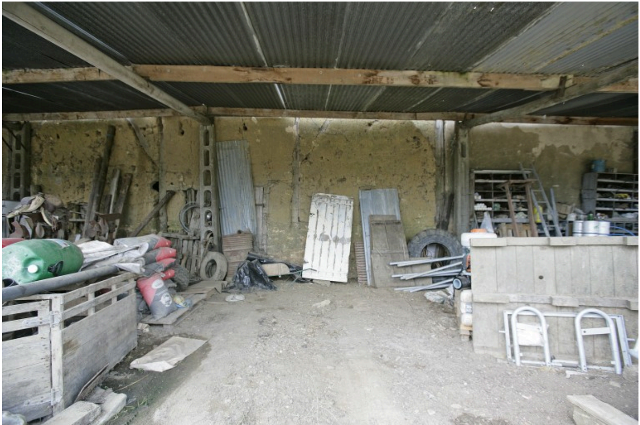
Grange : élévation postérieure en bauge.
