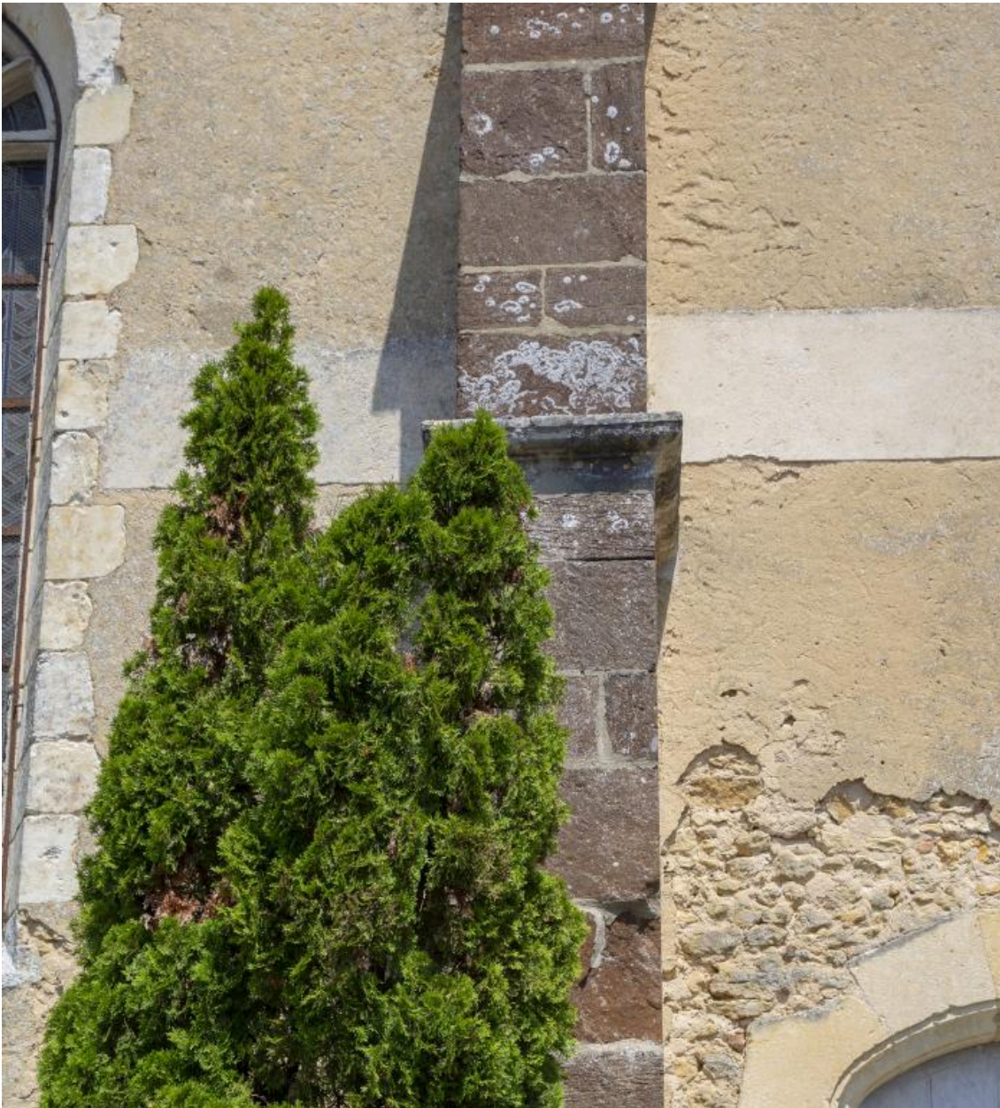
Un détail d'un contrefort et de la litre du mur sud.
