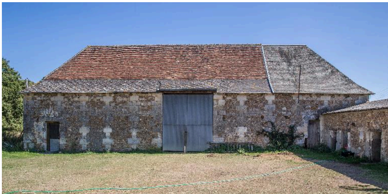
Grange-étable, façade sur cour.
