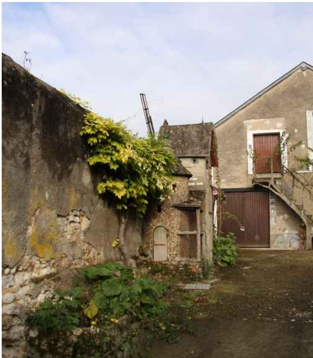
Façade antérieure, détail.
