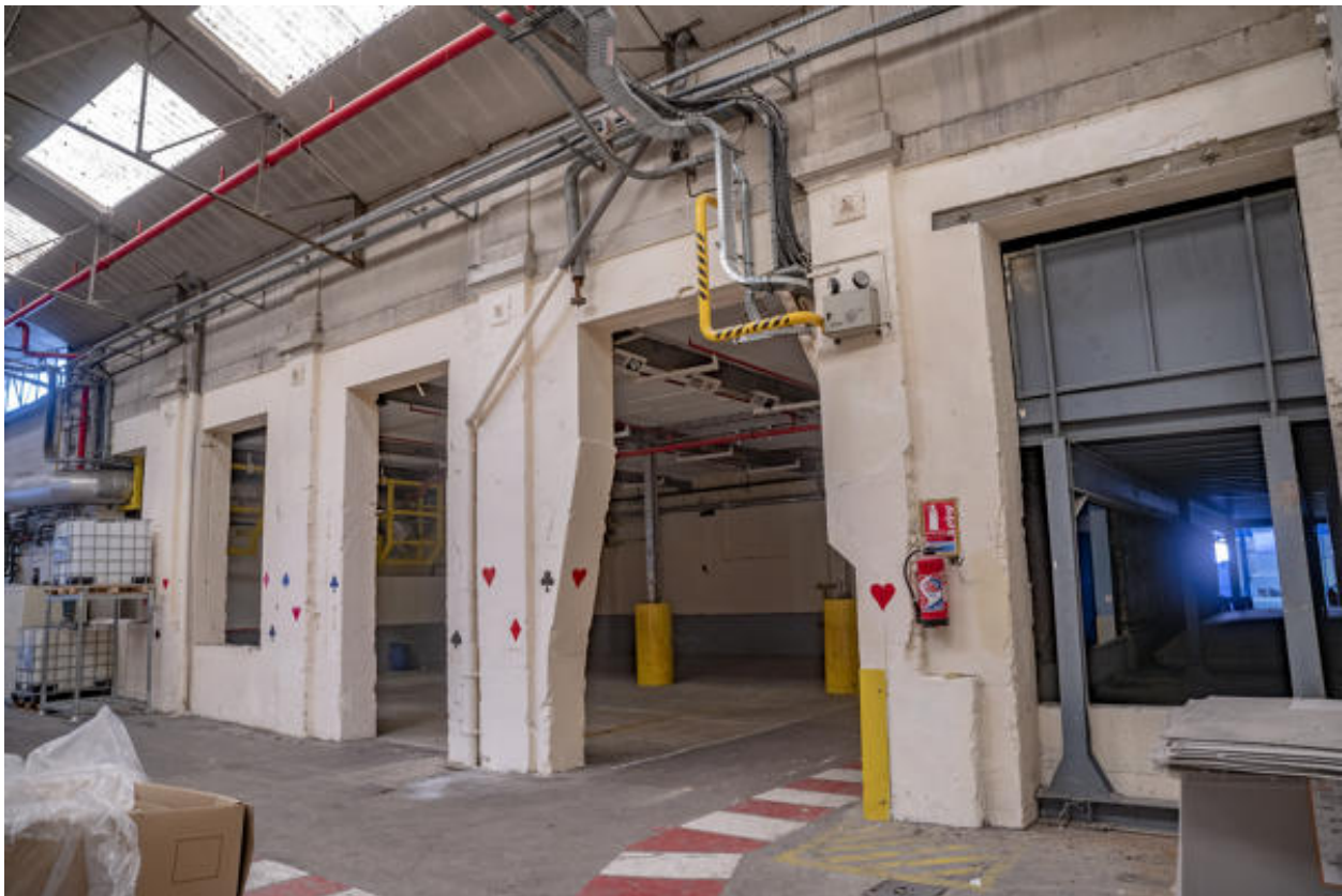
Ancienne élévation extérieure de l'atelier de couchage B, vue depuis l'atelier I.
