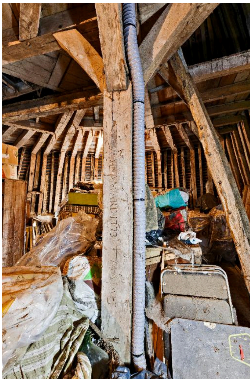
Vue partielle de la charpente de la tour sud : le premier niveau vu depuis l'est, avec l'inscription gravée sur la face est du poinçon.
