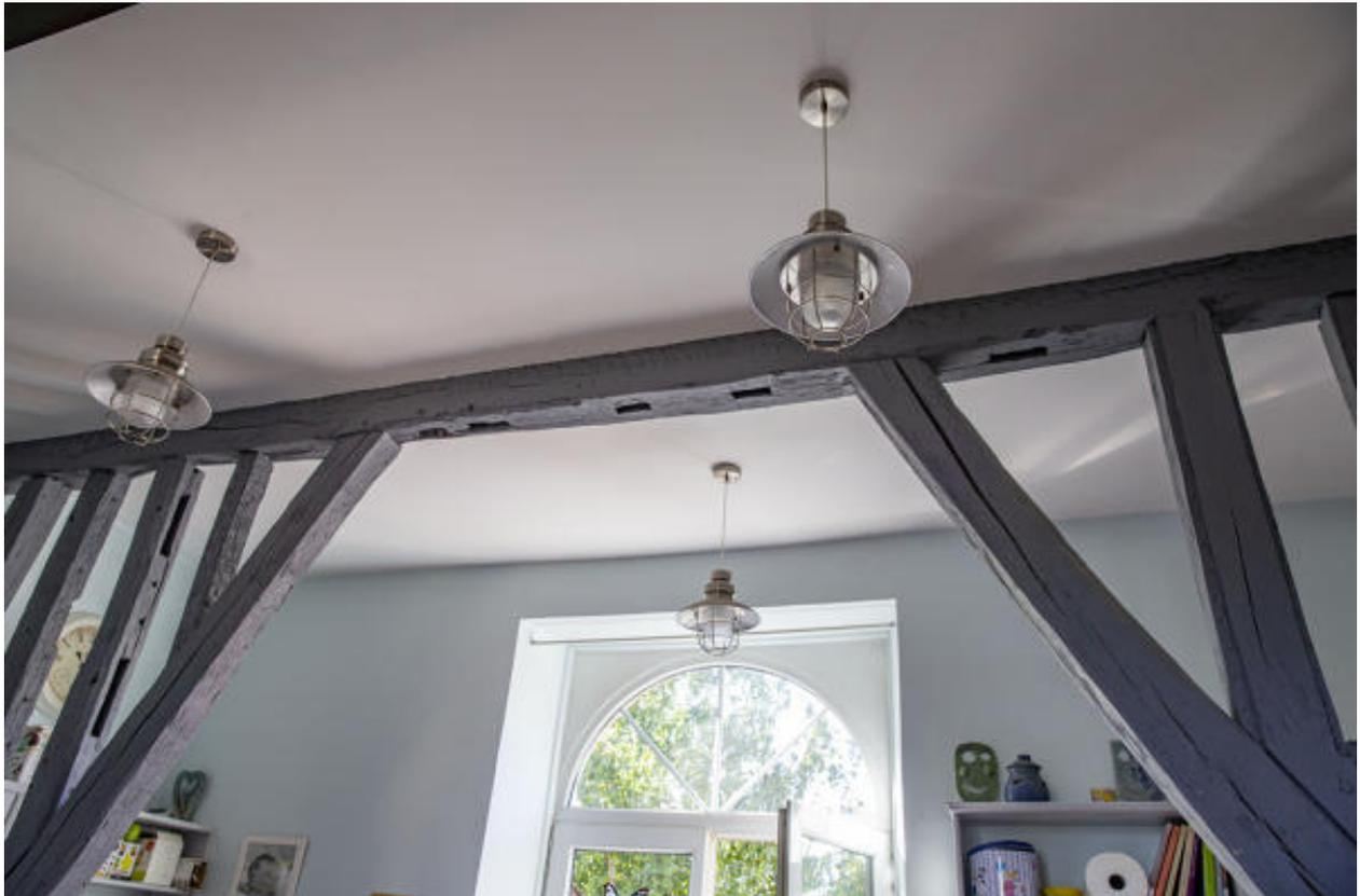
Détail d'une ancienne cloison en pans de bois en rez-de-chaussée.
