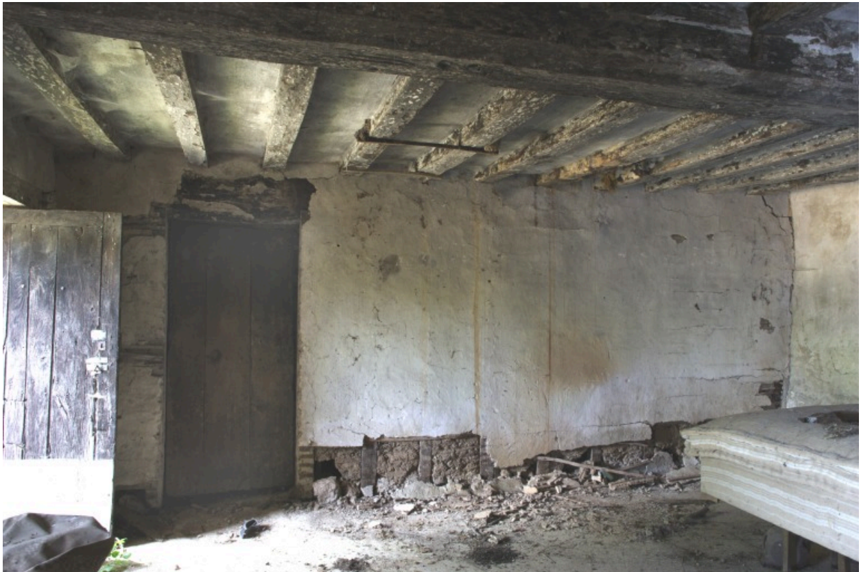
Le logis-étale ouest : la cloison séparant la pièce à cheminée de la pièce froide vue depuis la pièce à cheminée à l'est.
