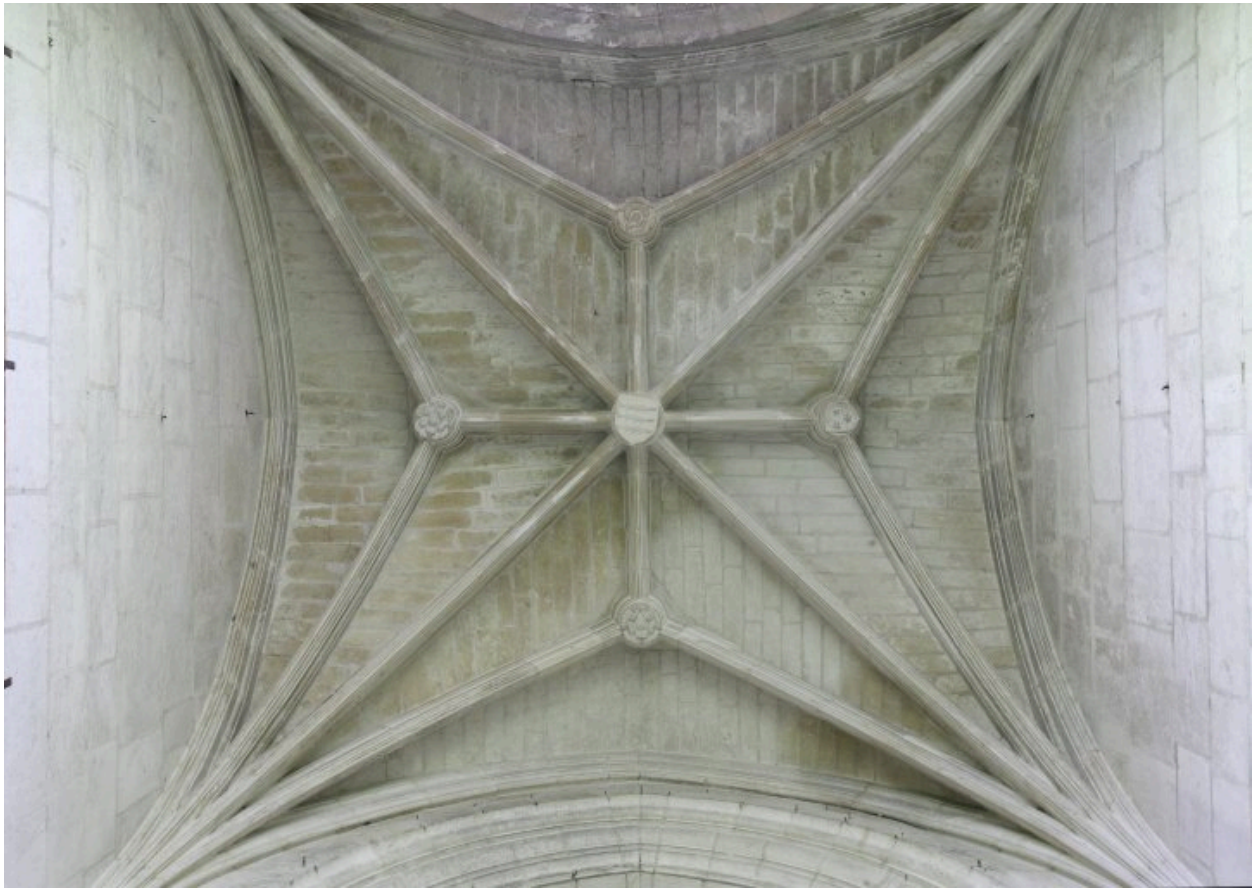
Quatrième chapelle du bas-côté sud de la nef : vue de la voûte, avec les armes du chapitre.
