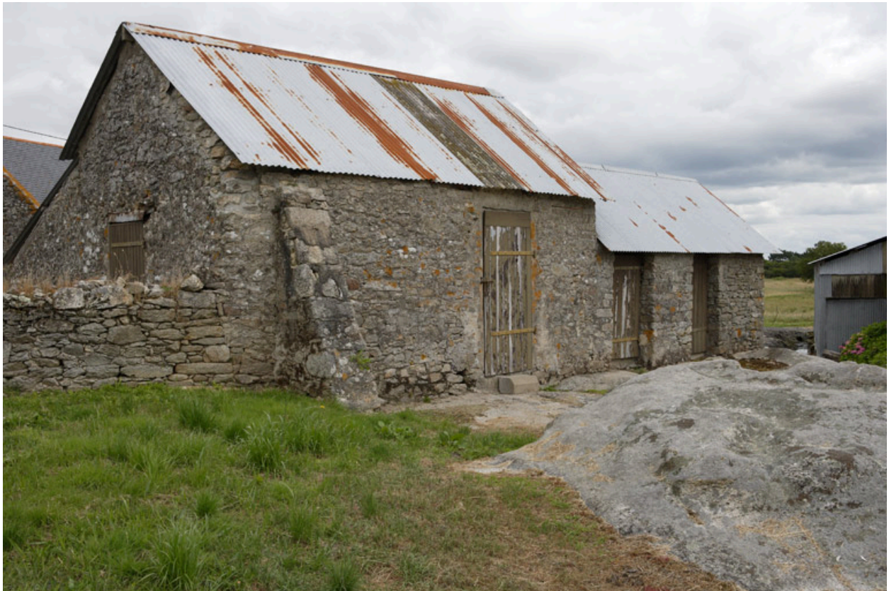
Vue des étable depuis le sud.
