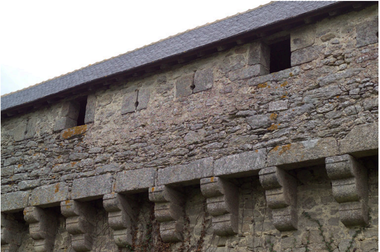
Détail du chemin de ronde et du mâchicoulis sur l'élévation gauche des anciennes écuries.
