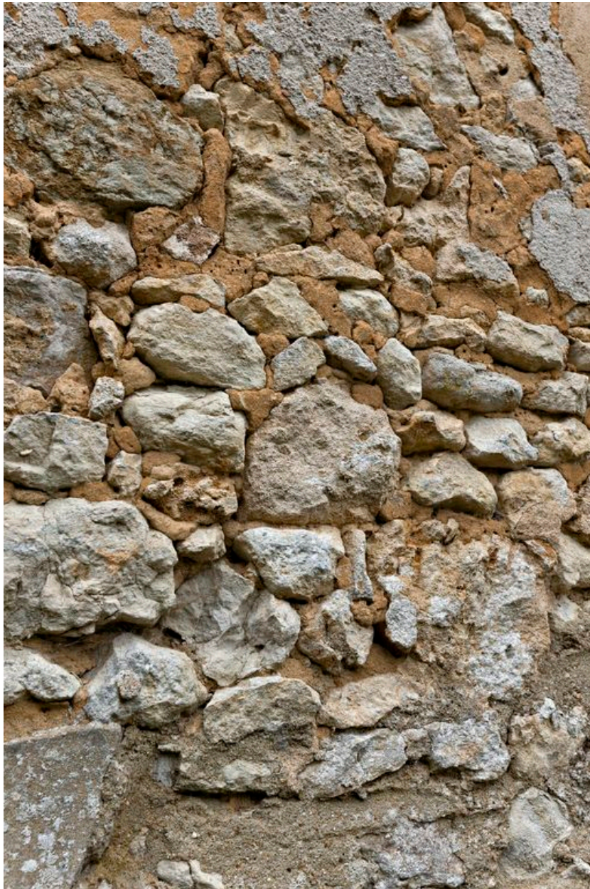
Détail du gros-oeuvre en moellons de calcaire du logis et moulin
