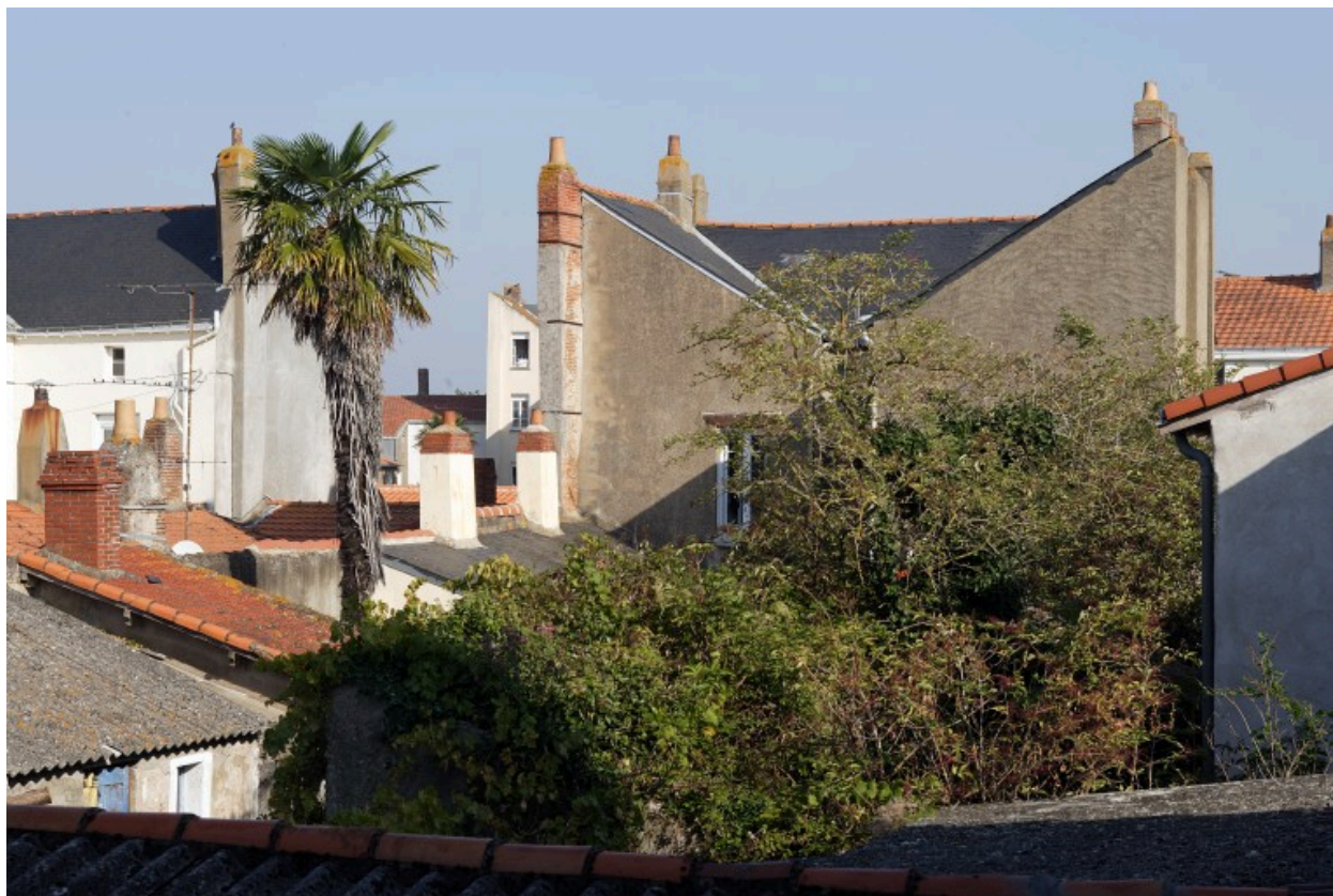
Les façades postérieures vues de l'escalier de la maison, 16 rue de l'Hôpital.
