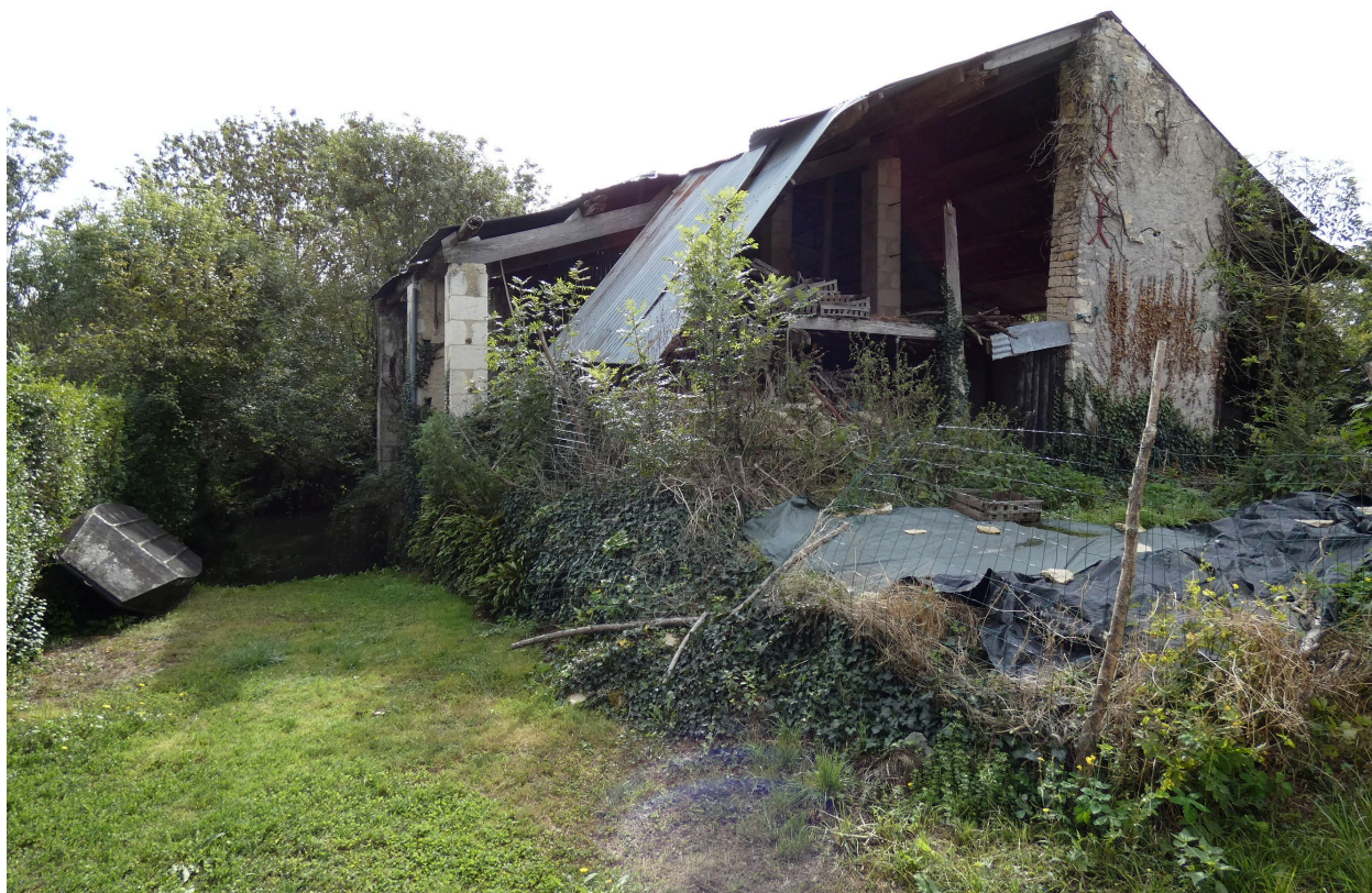
Le hangar vu depuis le nord.
