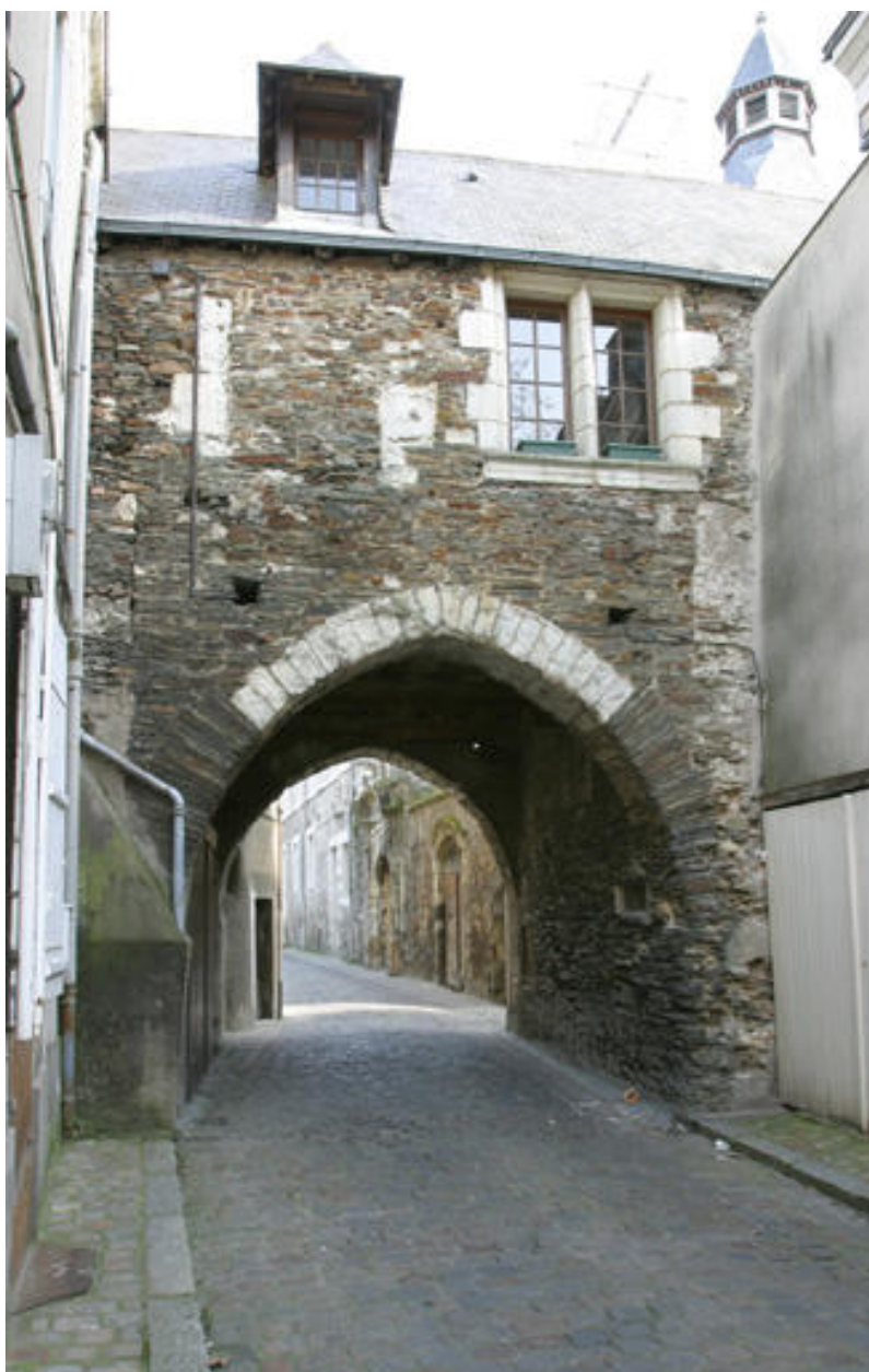
Abbaye, corps de passage vers la rue de la Censerie : face sud, place de la Laiterie.
