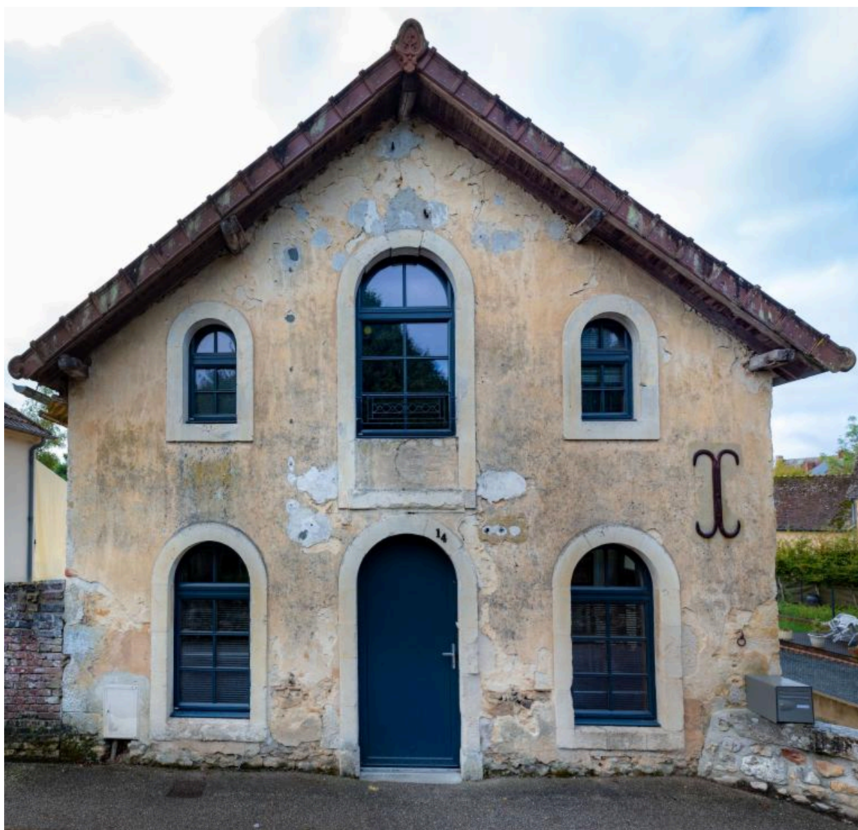
Le mur-pignon nord.
