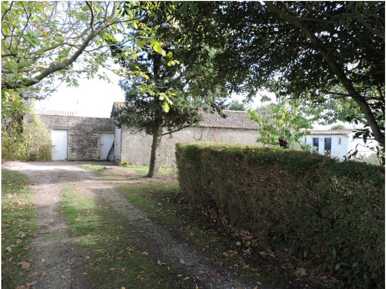
Les dépendances au sud de la maison, vues depuis l'ouest.
