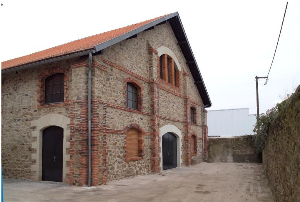
Bâtiment ouest. Mur-pignon nord.
