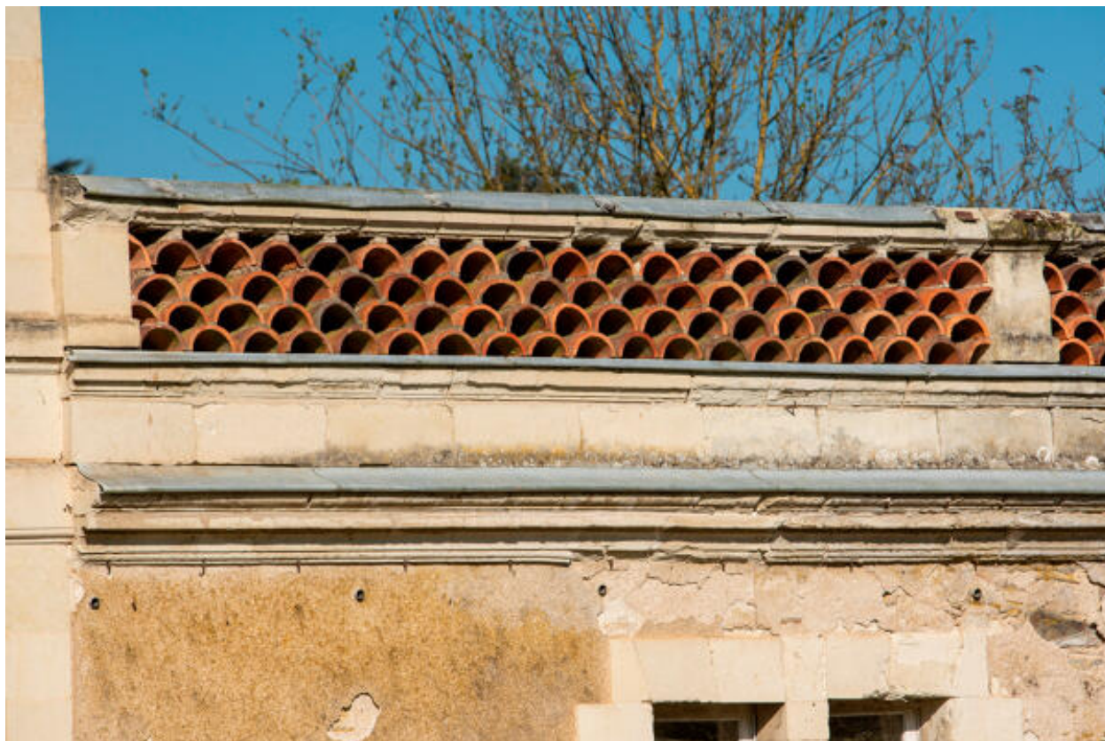
Le garde-corps couronnant l'aile nord.
